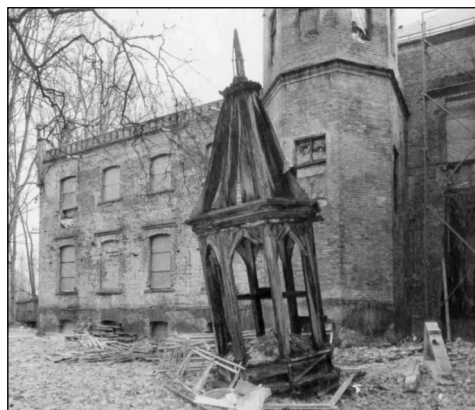
Rest des Turmes mit Wetterfahne von 1889 an der Westseite. Aufnahme 2012 (Volkmar Billeb)
